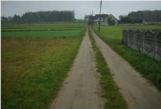
Droga w Dziewkach przed modernizacją
