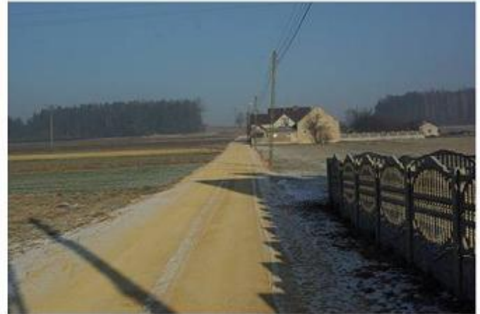
Droga w Dziewkach po utwardzeniu
