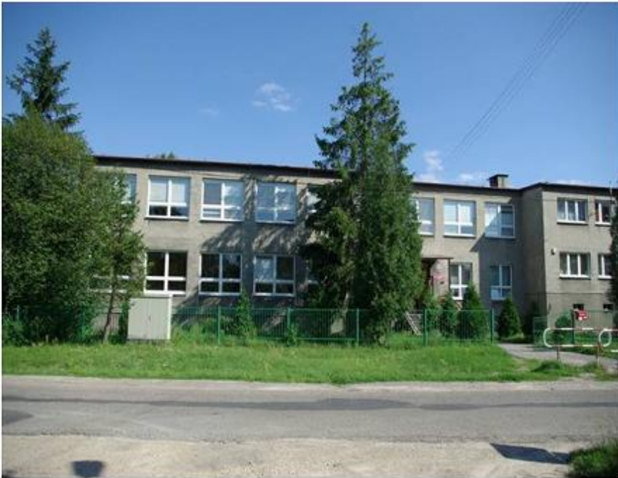
Szkoła Podstawowa Nr 2 w Siewierzu przed termomodernizacją
