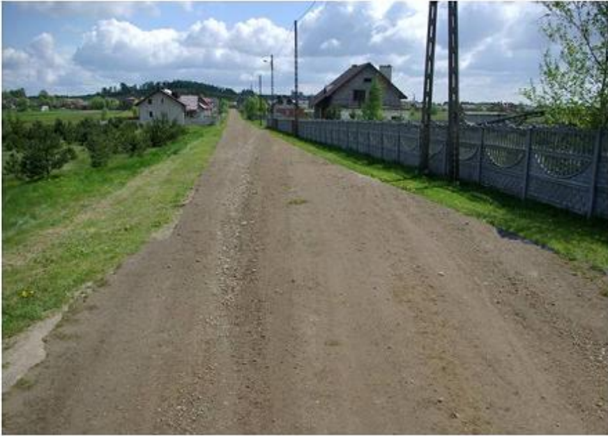
Ulica Osiedlowa w Brudzowicach przed remontem
