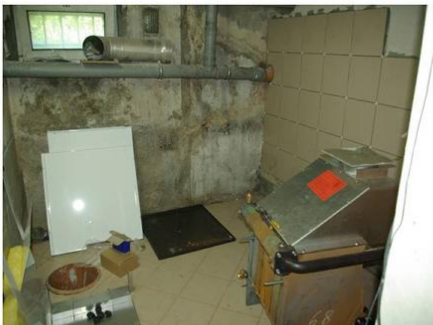
Kotłownia Przedszkola w Siewierzu w trakcie prac modernizacyjnych
