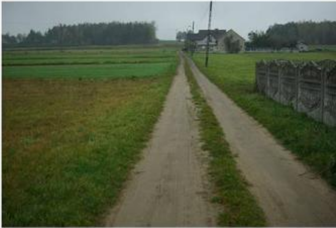
Droga w Dziewkach przed modernizacją
