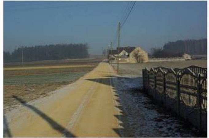
Droga w Dziewkach po utwardzeniu
