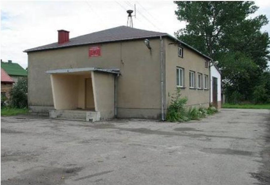
Remiza Ochotniczej Straży Pożarnej w Nowej Wiosce przed remontem
